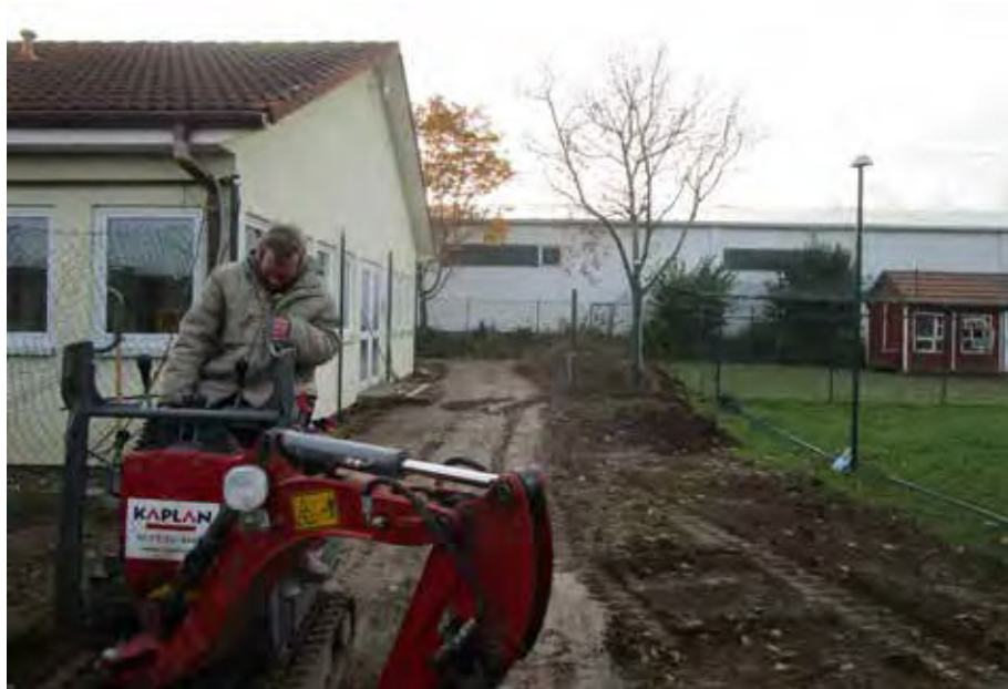
Die ersten Vorbereitungen für den Bau der neuen Besuchersanitäranlage haben begonnen (Fotos: Dr. Mareike Fellmin / WGH).
